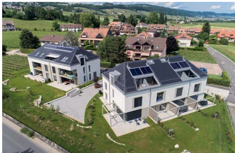
© GASSER CERAMIC Im Einsatz: Mehrfamilienhaus in Vich, 671 Module auf einer Dachfläche von 224 m 2 (Gesamtdachfläche 515 m 2 ). Dachdecker: Hanhart Toitures SA, 1260 Nyon
