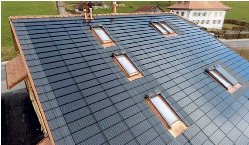
Liegenschaft in Botterens: 525 Module FIT 45 mit einer Leistung von 23,625 kWp und einer Gesamtproduktion von 19 410 kWh/Jahr. Dachdecker: Ruffieux Michel & Robert Sàrl, Charmey-Gruyère
