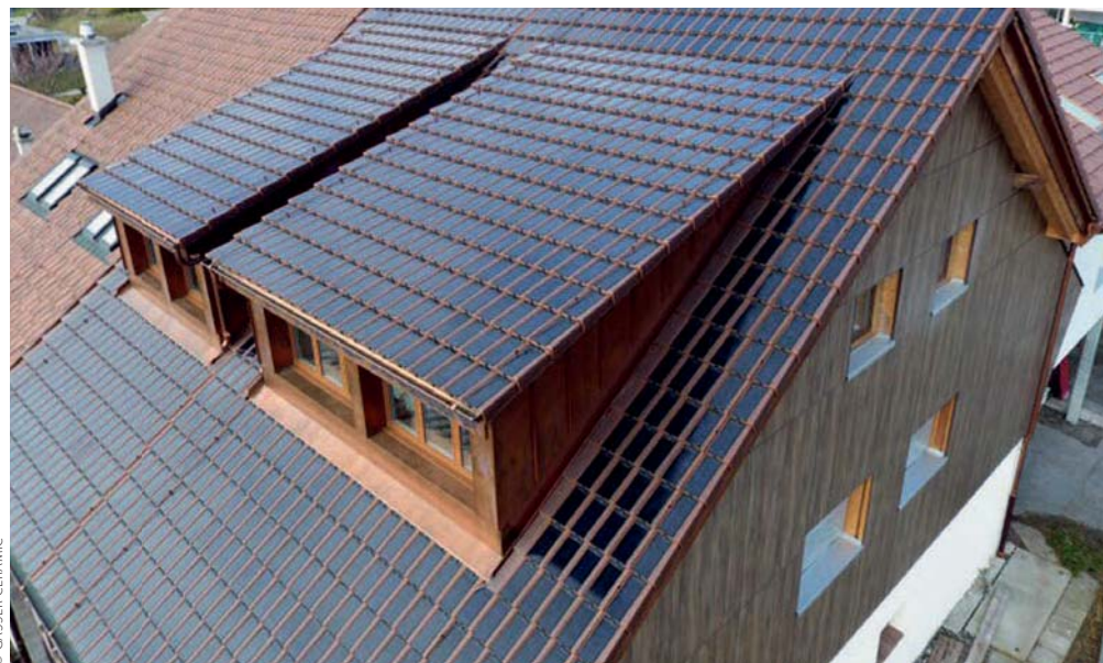
Doppeleinfamilienhaus in Lentigny: 296 Module PAN 29 mit einer Leistung von 8,288 kWp und einer Gesamtproduktion von 7 720 kWh/Jahr. Dachdecker: Alfred Jaquet, Lentigny
