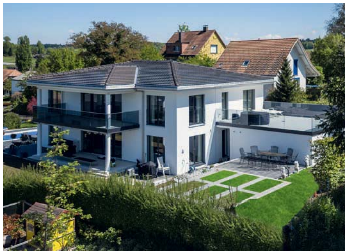
© GASSER CERAMIC Einfamilienhaus in Hessigkofen: 411 Module auf einer Dachfläche von 138 m 2 (verteilt auf 5 Dachteile in alle Himmelsrichtungen / Gesamtdachfläche 260 m 2 ). Dachdecker: E. Jörg AG, Bätterkinden
