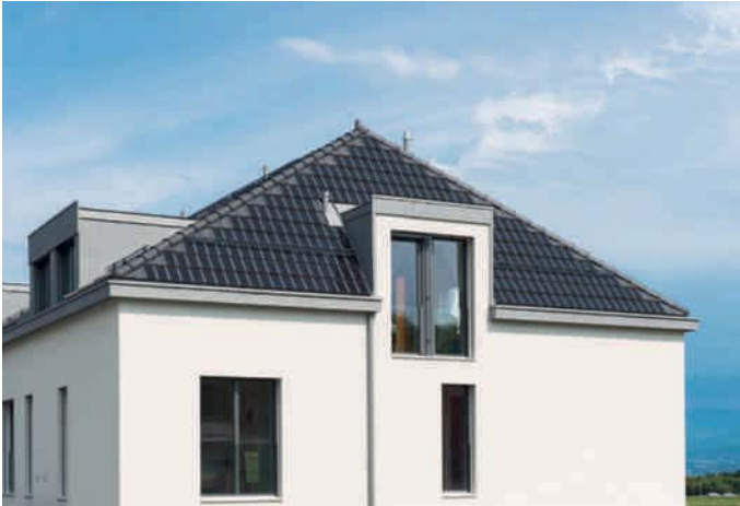
PAN 29 im Einsatz, zwei Mehrfamilienhäuser in Vich: 671 Module, verteilt auf 224 m 2 bei einer Gesamtdachfläche von 515 m 2 . Die Gesamtleistung der Anlage beträgt 16,775 kWp, die Jahresleistung 16 968 kWh.
