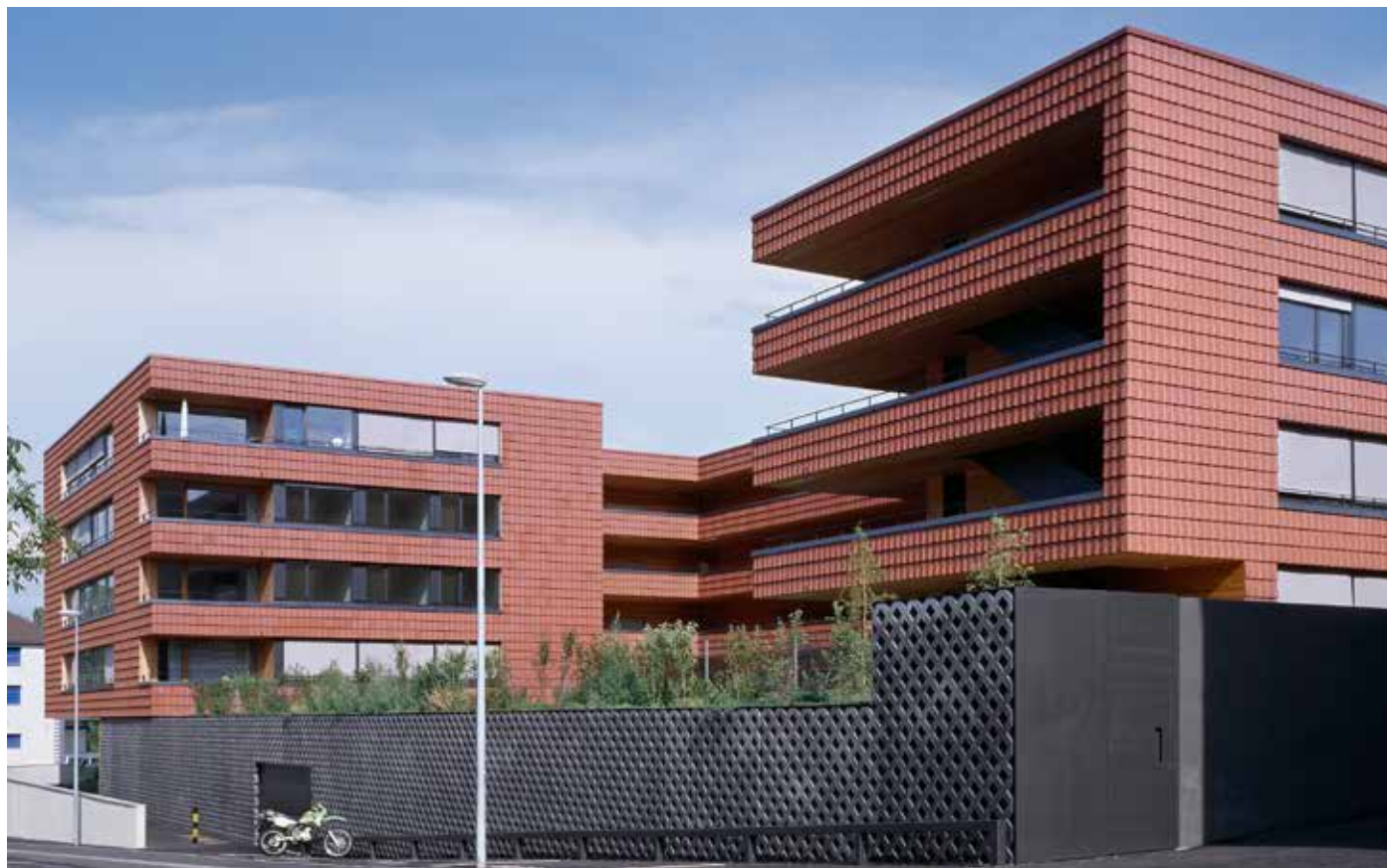
Der Tonziegel Joran wurde eigentlich für das Dach konzipiert, bei der «Wohnüberbauung Le Noyers» jedoch zu einer cleveren Fassadenlösung umfunktioniert.
