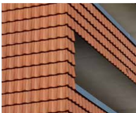
Tondachziegelfassade FOTO: MORANDI
