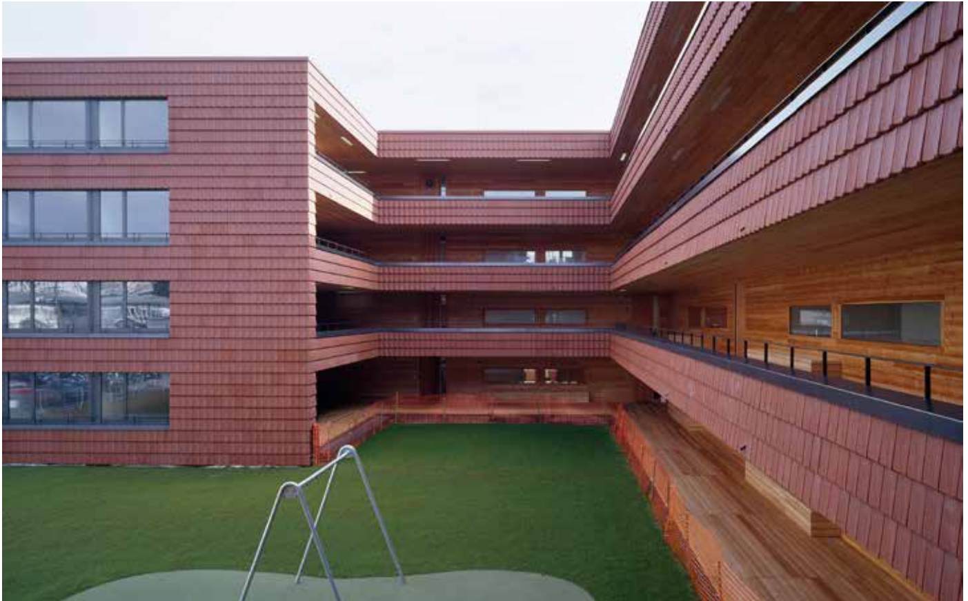
Die «Wohnüberbauung Le Noyers» beweist, günstiges Bauen in einem zeitgemässen und ästhetischen Stil ist möglich.
