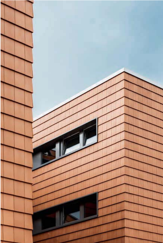
Eine Ziegelfassade vereint Vorteile wie Ästhetik, Energieeffizienz und Nachhaltigkeit.
